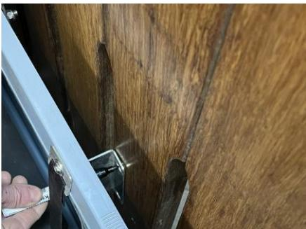
Si le trou pour les câbles de connexion n'est pas encore percé dans le mur, vous pouvez le marquer maintenant. Retournez la base d'alimentation vers vous afin que ce trou situé dans la partie inférieure droite arrière du FeedingMaster soit visible.
