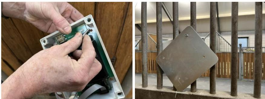
Bestimmen Sie die richtige Länge der zu verwendenden Schrauben. Beginnen Sie mit der kürzesten Schraube und führen Sie sie durch die Befestigungsbohrung in der unteren rechten Ecke des Controllers durch die Stangen. Setzen Sie die Montageplatte über die Schraube und messen Sie den Abstand, um den sie herausragt.
