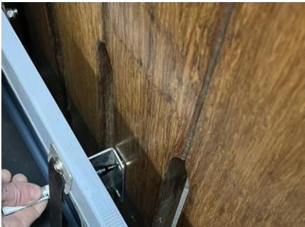
Wenn das Loch für die Verbindungskabel noch nicht durch die Wand gebohrt ist, kann es jetzt markiert werden. Klappen Sie die Futterbasis zu sich hin, sodass dieses Loch unten rechts hinten am FeedingMaster sichtbar wird. Führen Sie einen Filzstift oder Bleistift durch das Loch und markieren Sie das Loch an der Wand. Senken Sie den Boden wieder vorsichtig ab.
